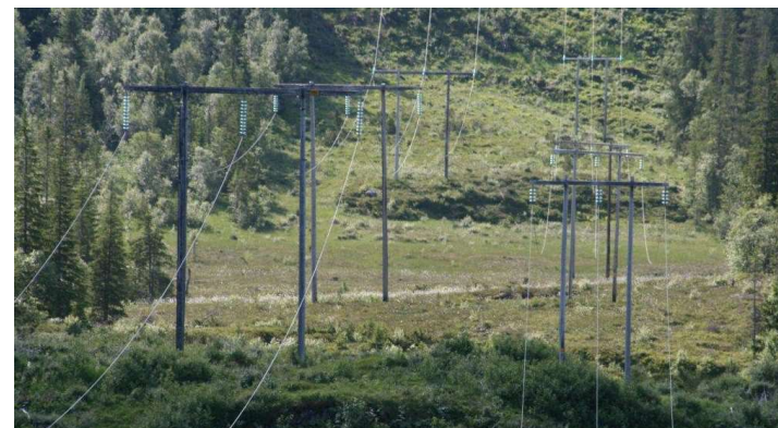
Bildet viser eksempel på høyspentlinjer. 132 kV-linje til venstre og 22 kV-linje til høyre.
